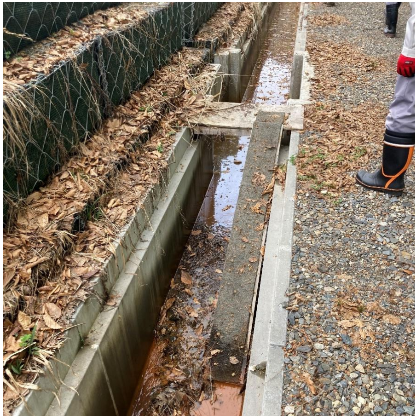
写真4-11 電源開発株式会社が側溝に設置した小動物の這い出しスロープ
