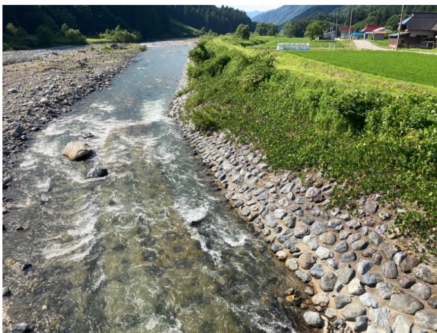
写真 4-8 2011 年 7 月新潟・福島豪雨の後の河川改修で築かれた護岸（右岸部、倉谷）。周辺景観に調和するように現地の自然石が護岸に埋め込まれたが、その結果、淡水魚などの生息環境となる河床の浮石が失われた。5.5-(7)で記述する自然力を活かした内水面漁業振興を推進するためにも、淡水魚類の生息に適した環境を保全する河川管理が求められる。
