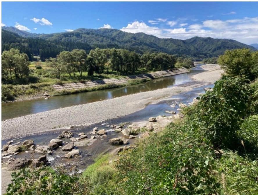
写真 4-7 2011 年 7 月新潟・福島豪雨の後の河川改修で既存の堤防の外に新たに堤防が築かれた（左岸部、大倉）。河川攪乱の影響が及ばない堤防内にユビソヤナギ S. hukaoana を含む河畔林が封じ込められ、ユビソヤナギ S. hukaoana は河川攪乱体制に依存して更新するため、ここの個体群は更新困難となり、衰退していくと考えられる。
