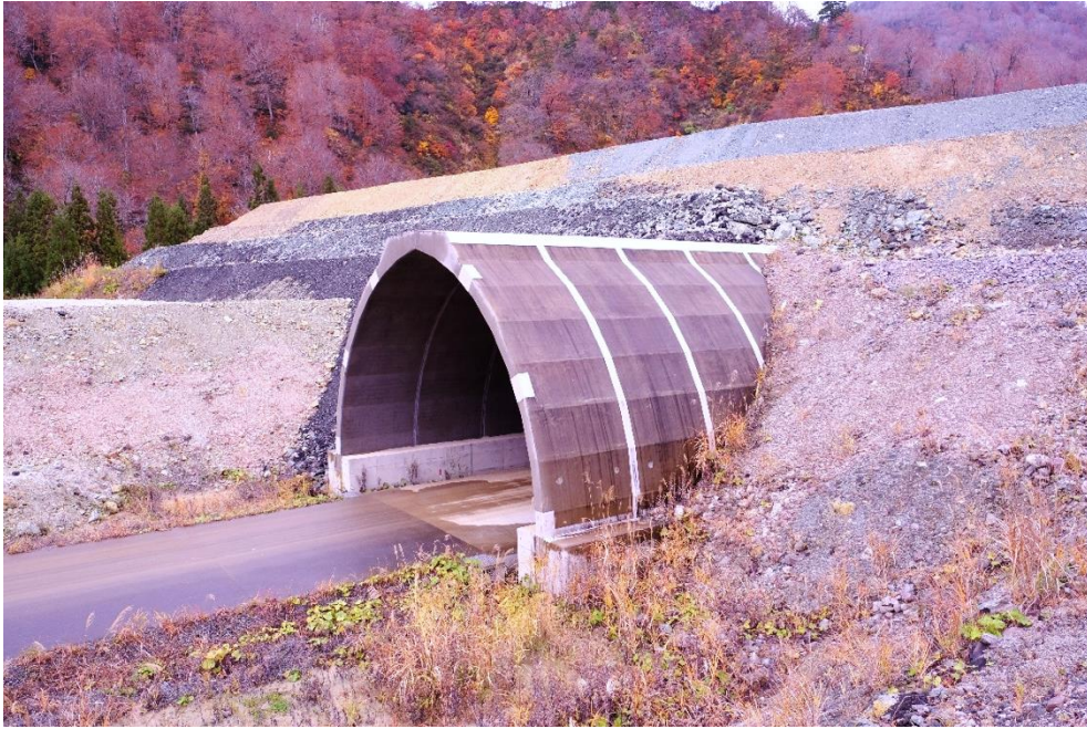
写真 4-5 トンネル掘削土砂置場。他地域由来のブナ F. crenata の植栽による緑化が計画されていたが、只見ユネスコエコパーク支援委員会から法面傾斜を緩くすることで土砂流出を防ぐほか、自然の植生遷移を利用した緑化が提案されている。
