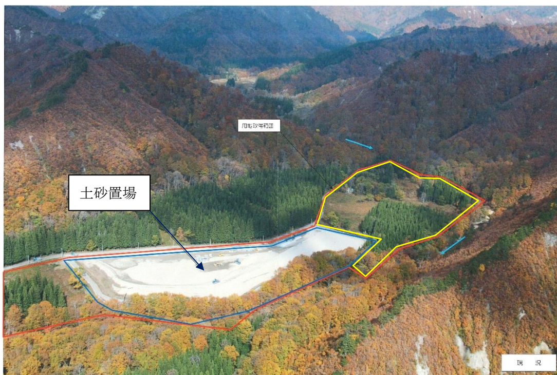
図 4-4 Tadami BR 北西部の蒲生川流域の浚渫土砂置場概況（青線内：既造成済み土砂置場面積、40,0290 m 2 、黄線内：2023 年より新規造成予定地、56,647 m 2 ）。さらに上流域、あるいは他流域の土砂置場造成も検討されている。 （電源開発株式会社東日本支店田子倉電力所作成資料より）
