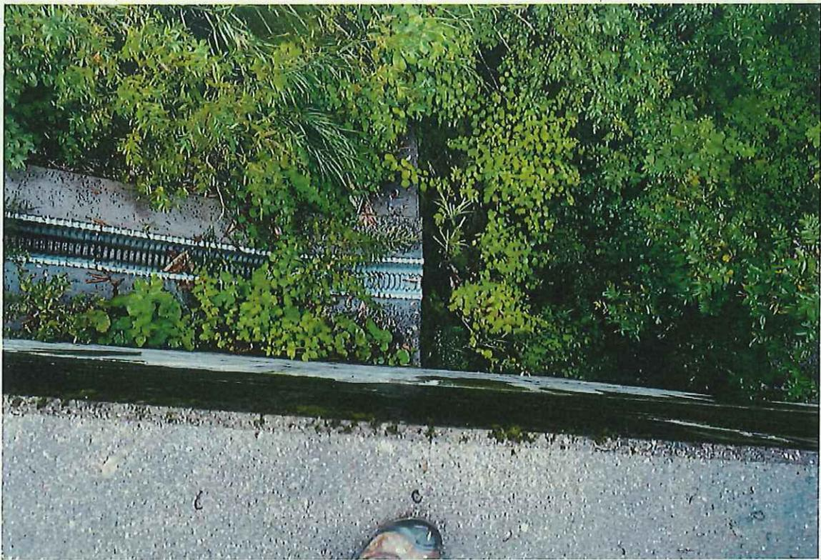
写真 3 流水を放出する人工構造物と溪流・河川や山地斜面との間の連続性が断たれている
