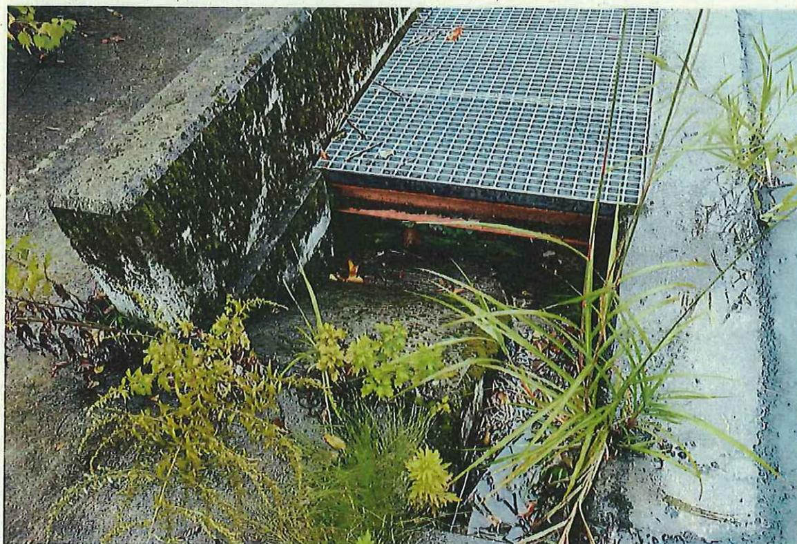
写真2 段差が設けられ小動物が脱出に配慮された集水枥
