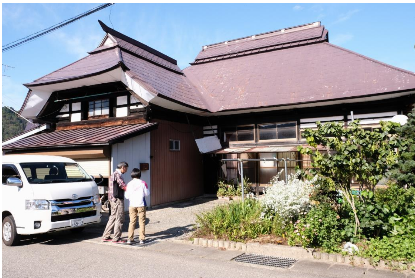
古民家調査の様子
