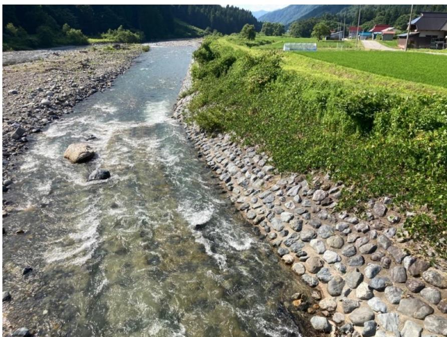
写真 4-8 2011 年 7 月新潟・福島豪雨の後の河川改修で築かれた護岸（右岸部、倉谷）。周辺景観に調和するように現地の自然石が護岸に埋め込まれたが、その結果、淡水魚などの生息環境となる河床の浮石が失われた。5.5-(7)で記述する自然力を活かした内水面漁業振興を推進するためにも、淡水魚類の生息に適した環境を保全する河川管理が求められる。
