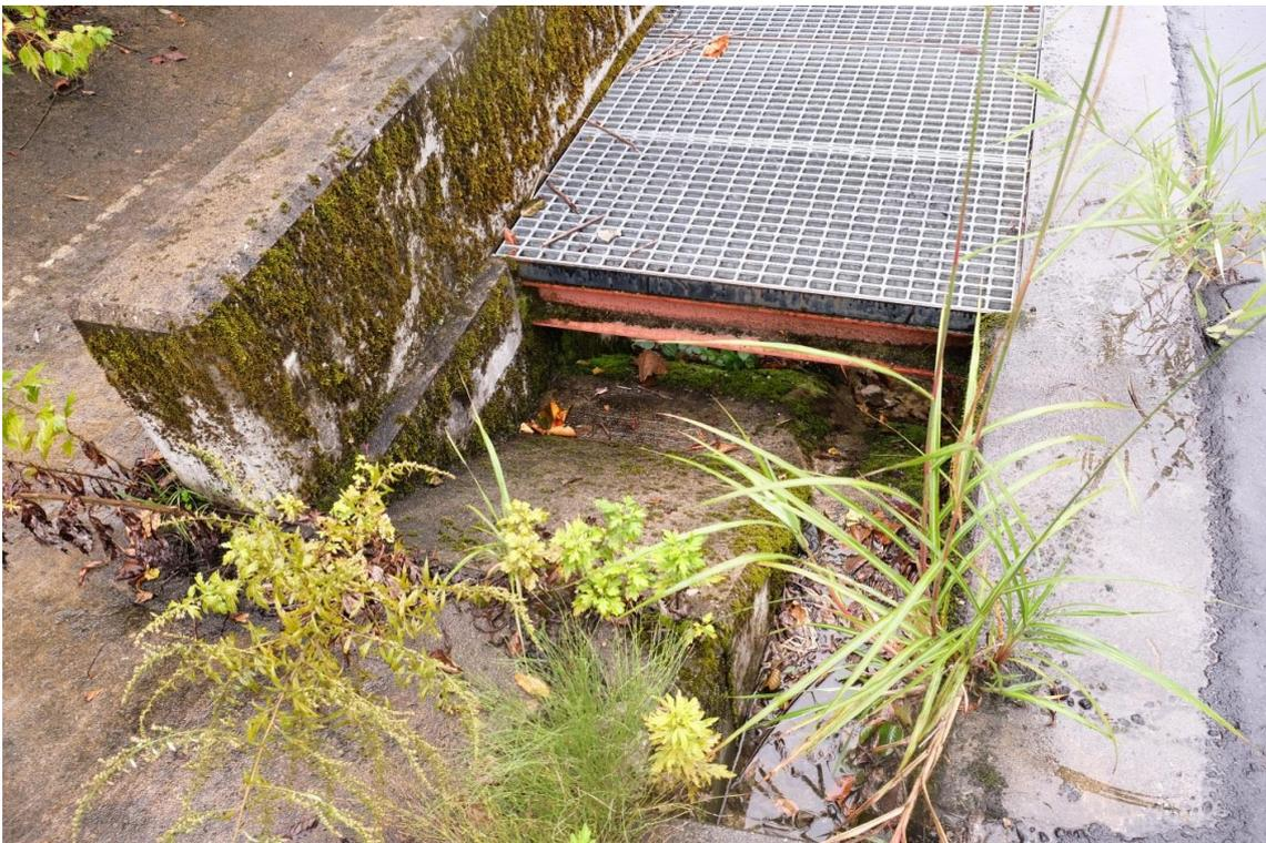
写真2 段差が設けられ小動物が脱出に配慮された集水枡
